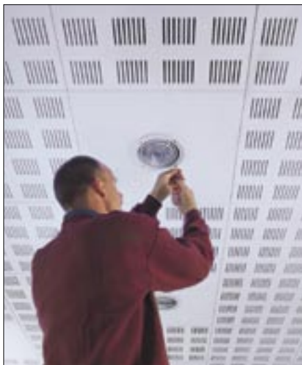
Gyptone loftplader kan belastes med f.eks. lamper, ventilationsventiler m.v.
